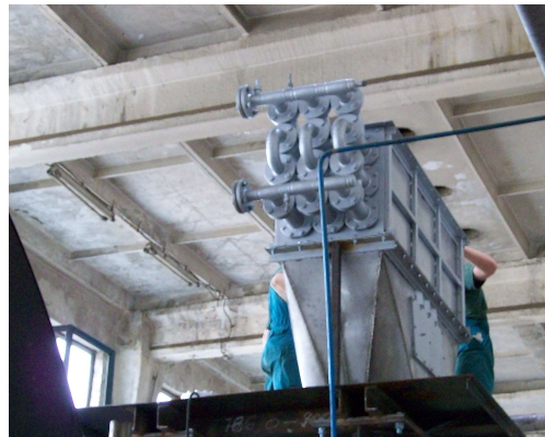
Montaj Recuperator caldura cu PTT
