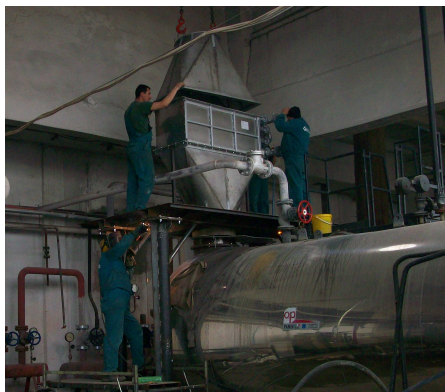
Montaj reductie aval
