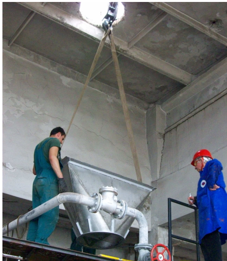
Montaj reductie amonte
